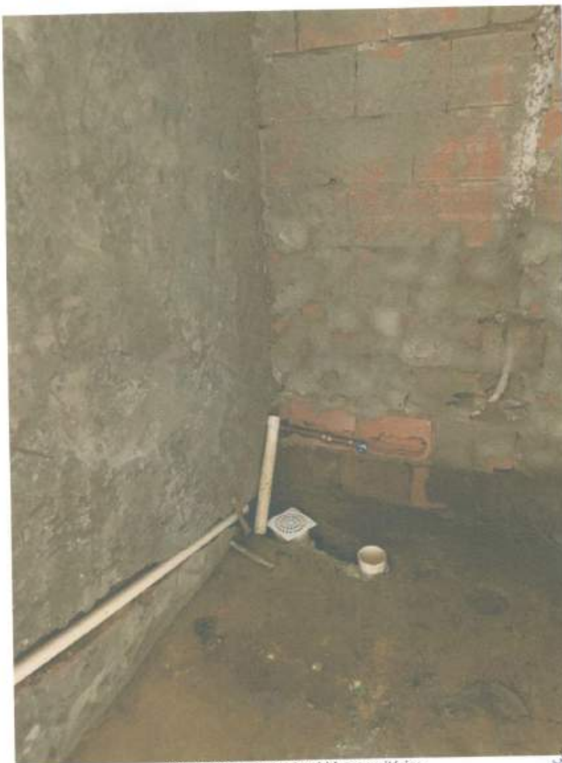
Chapisco e tubulações hidrosanitárias
