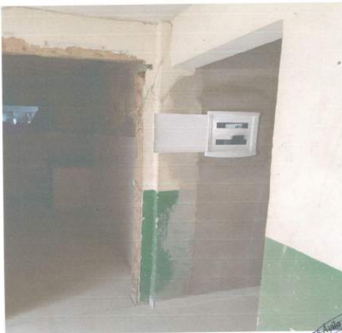
Execução de piso e quadro de distribuição
