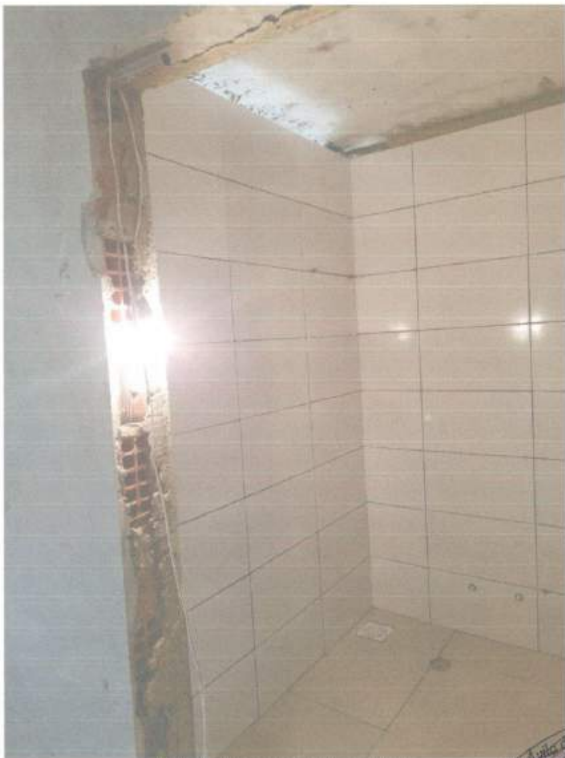
Revestimento nos banheiros acessíveis
