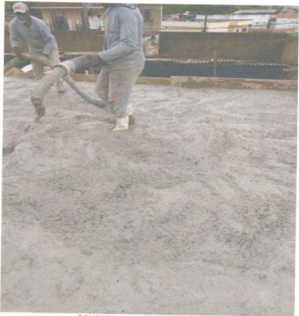
CONCRETAGEM DE VIGAS E PILARES
