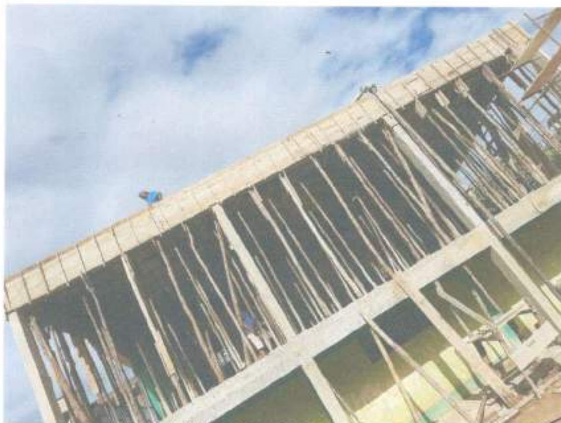
ESTRUTURA MONTADA DE LAJE E VIGAS
