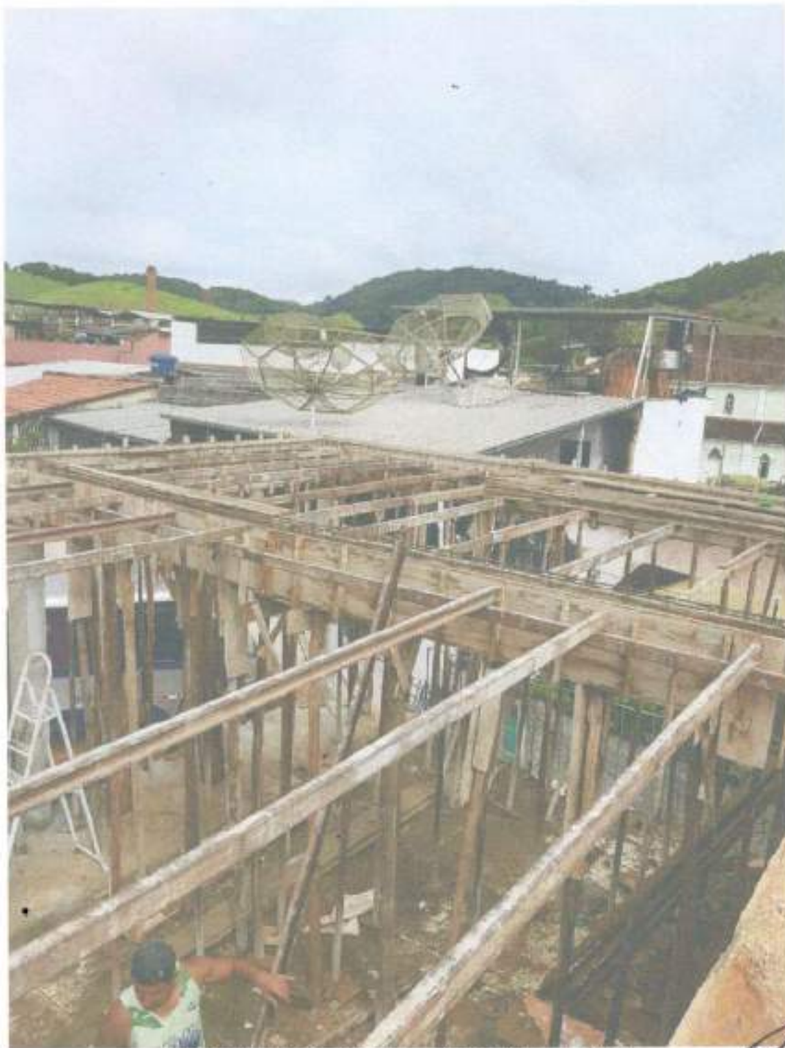
MONTAGENS DE VIGAS E LAJES DO PLENÁRIO
