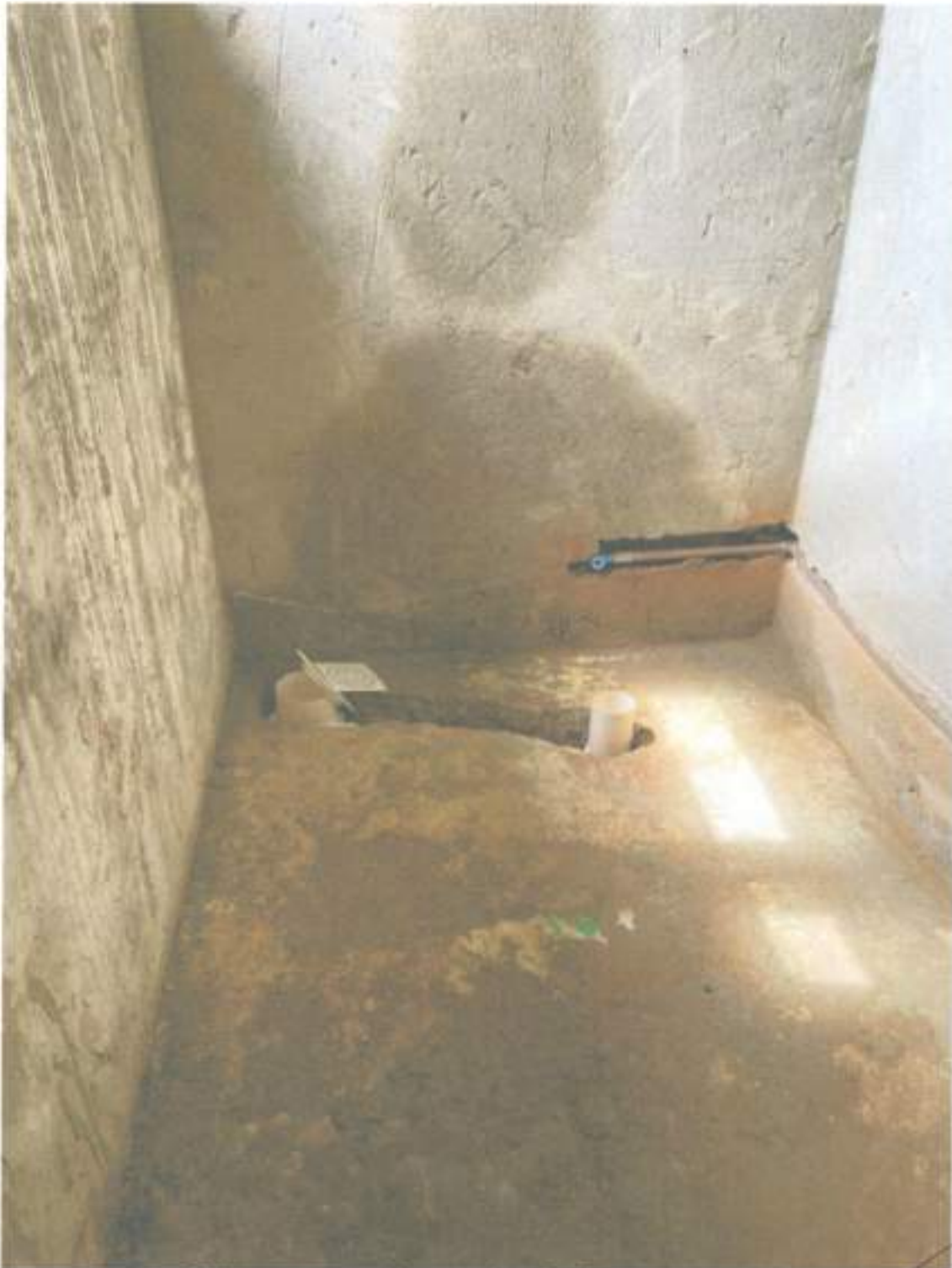
Emboço para recebimento de cerâmicas nas paredes
