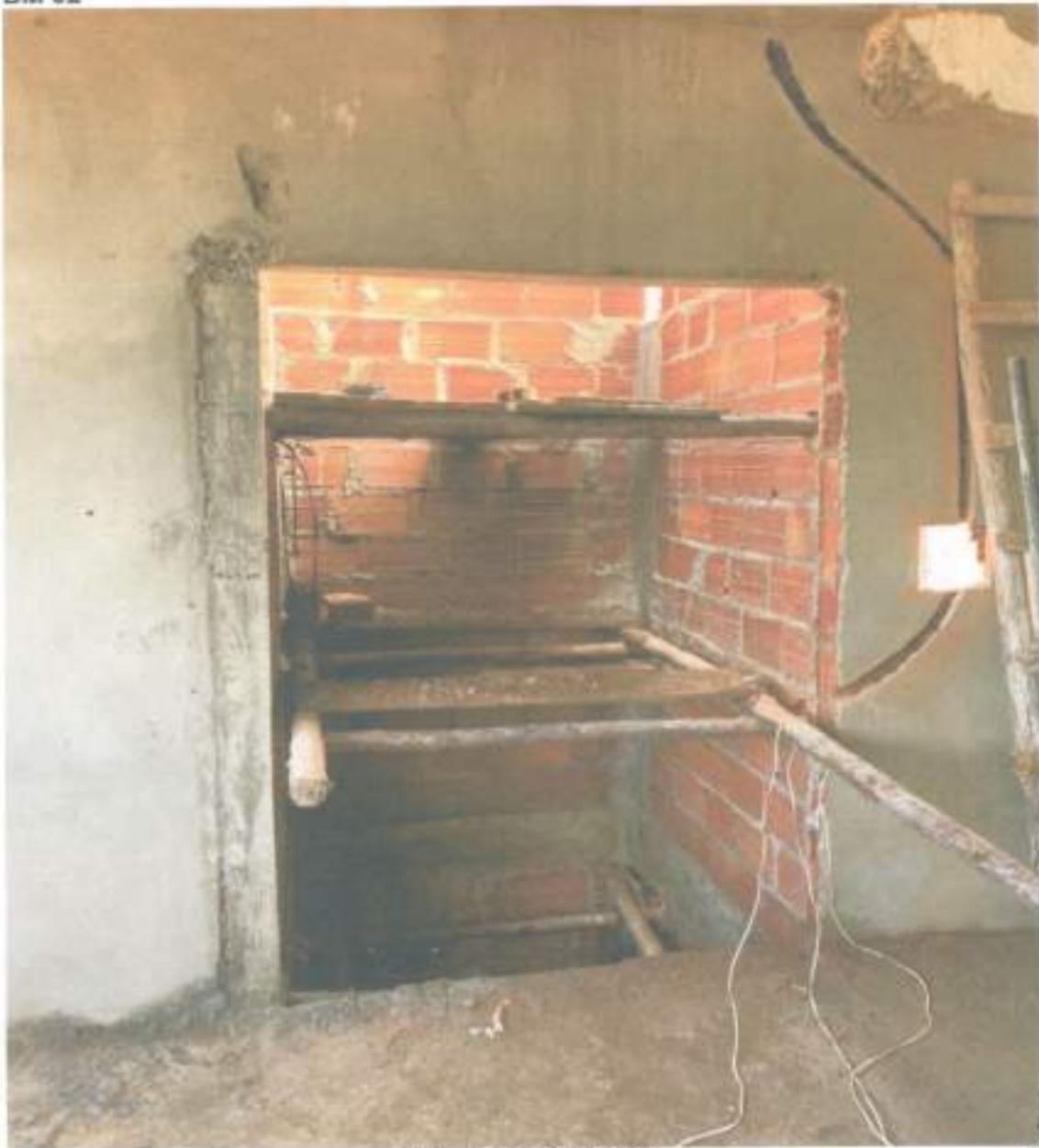
Emboço parte interna
