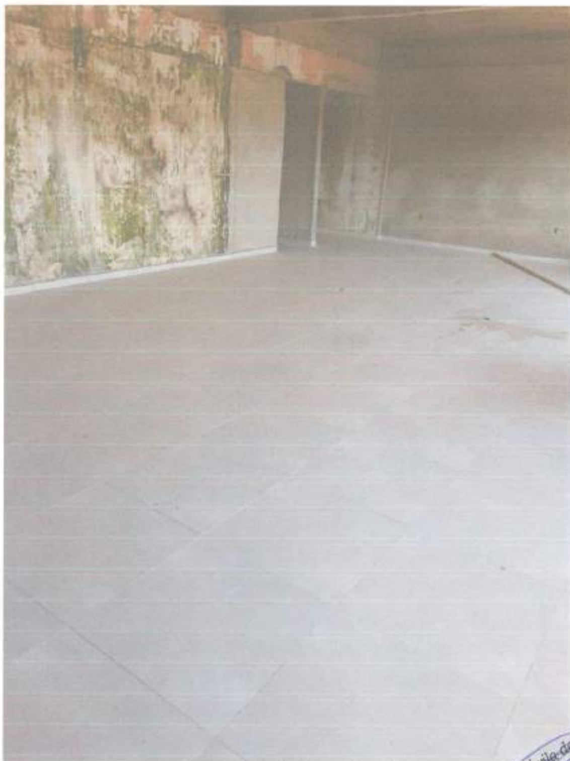
Assentamento de piso no plenário
