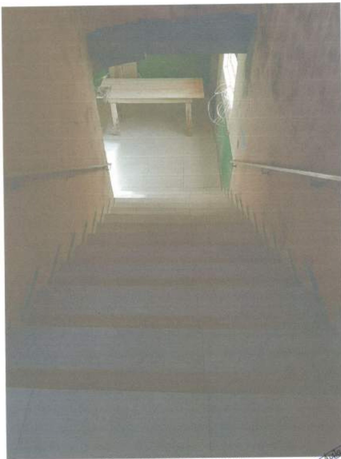
Escada do térreo para o 1º pavimento
