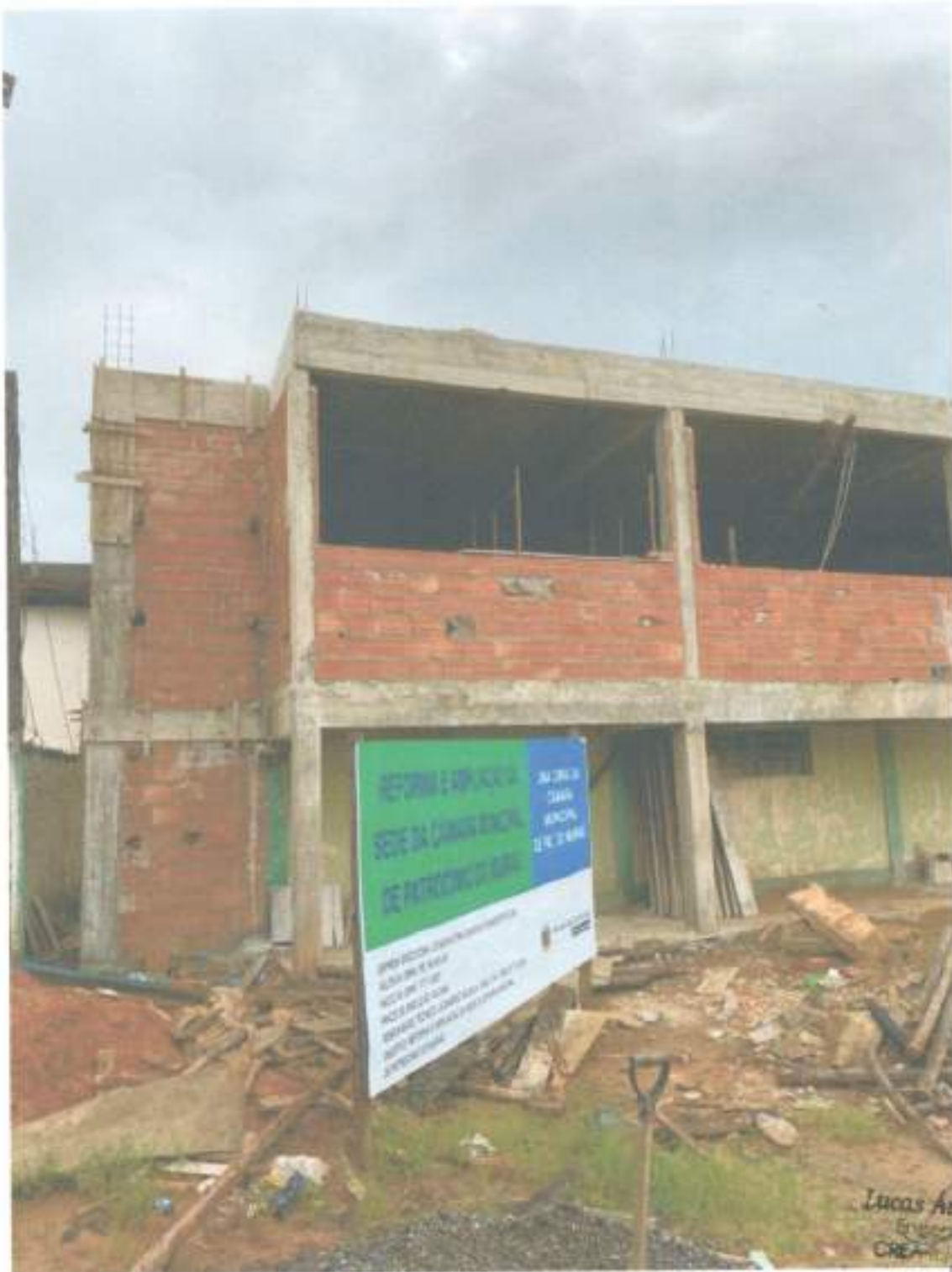
Alvenaria de vedação
