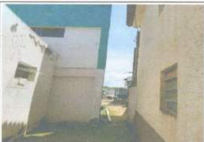
FIGURA 04 - BECO DE ACESSO AS INSTALAÇÕES ELÉTRICAS
