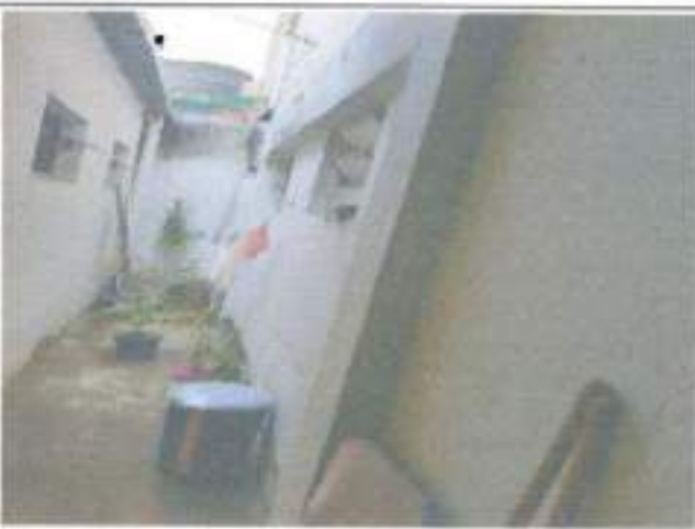
FIGURA 05 - BECO DE VENTILAÇÕES E TUBULAÇÕES SANITÁRIAS
