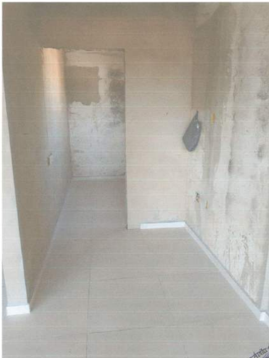
Sala de controles
