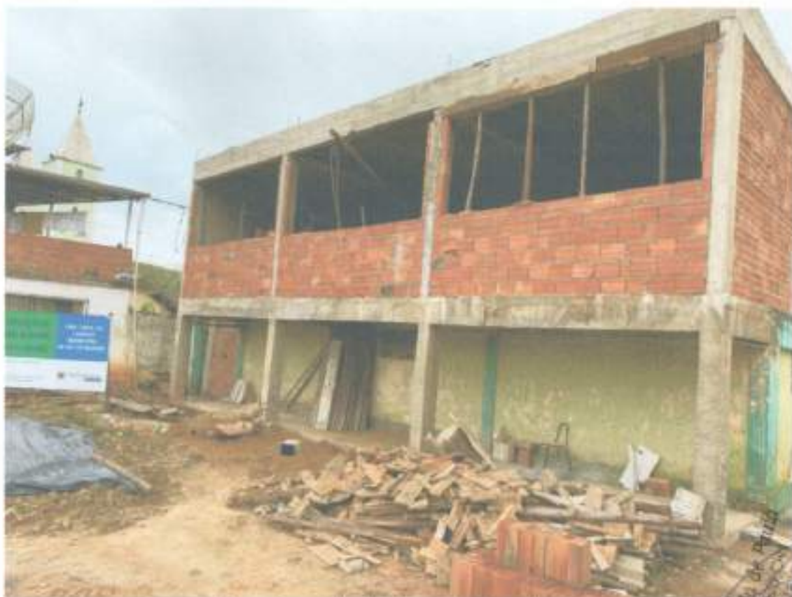
Assentamento de alvenaria de vedação
