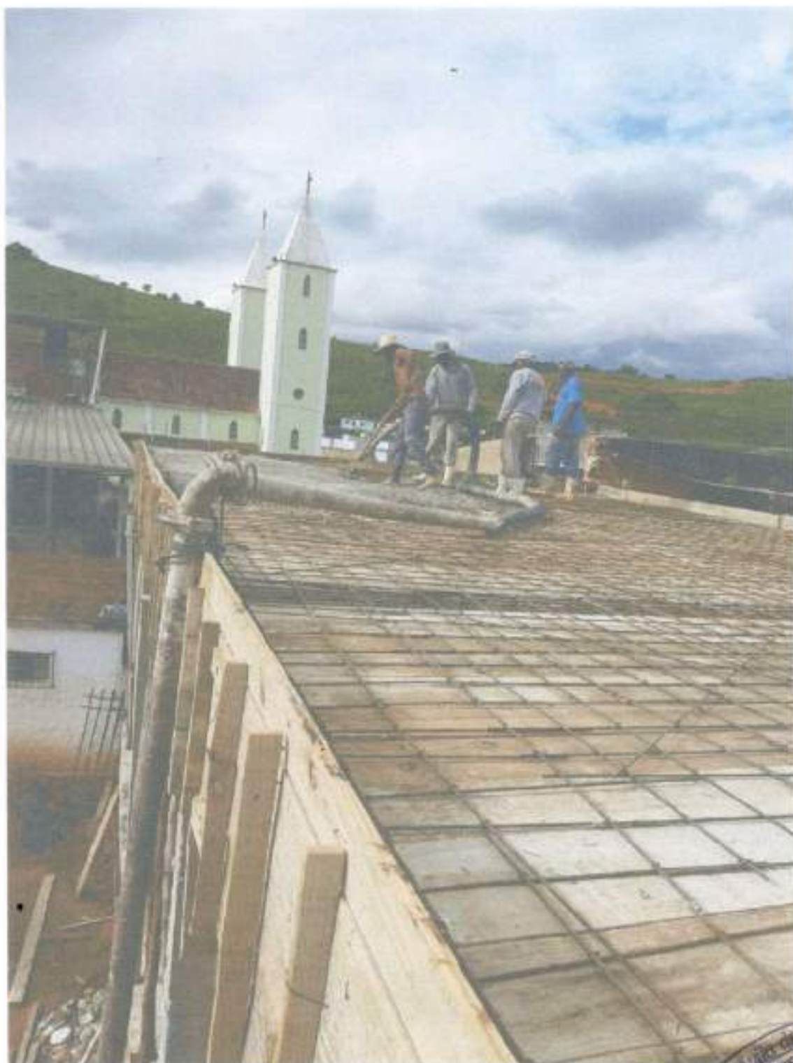
CONCRETAGEM DE LAJES E VIGAS
