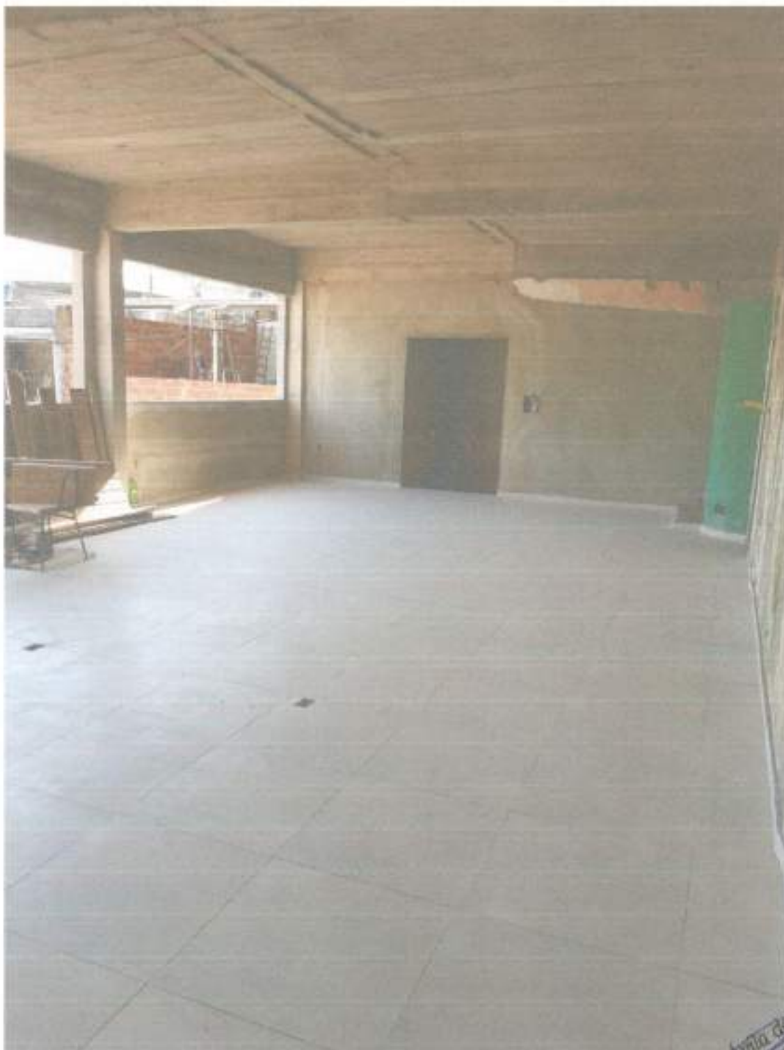
Assentamento de piso no plenário
