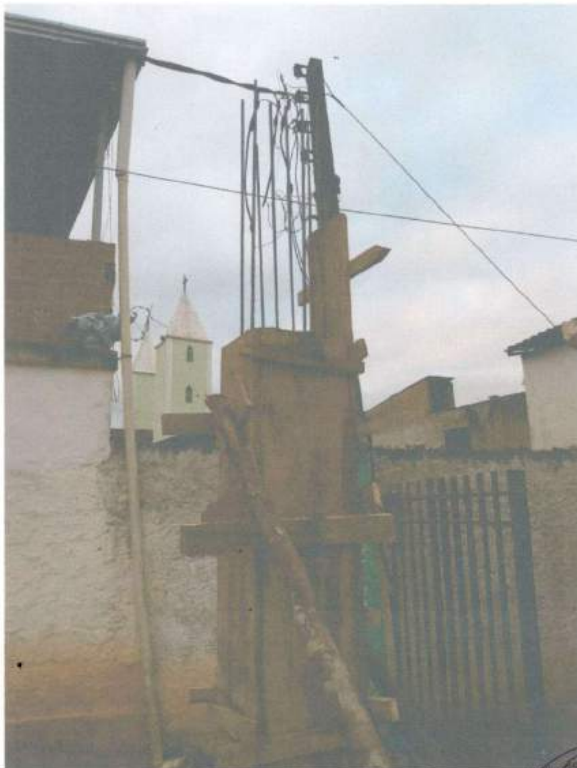
ENCHIMENTO DE PILARES DA AMPLIAÇÃO
