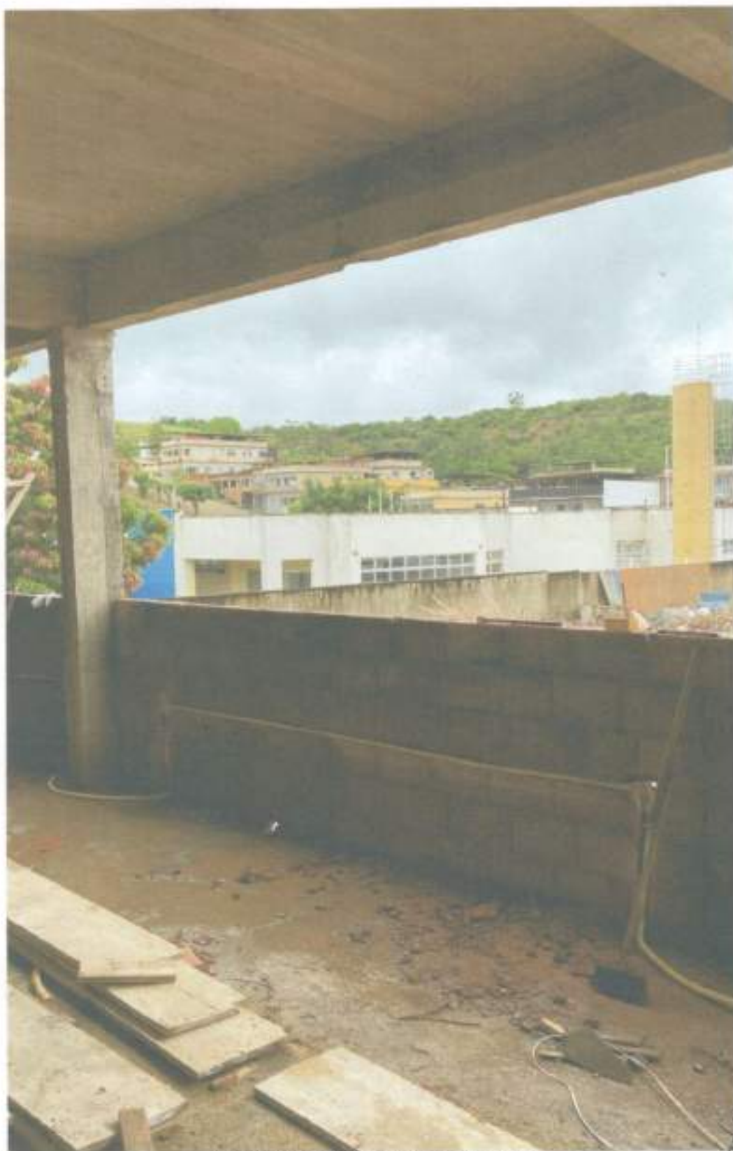
Chapisco e tubulações de energia
