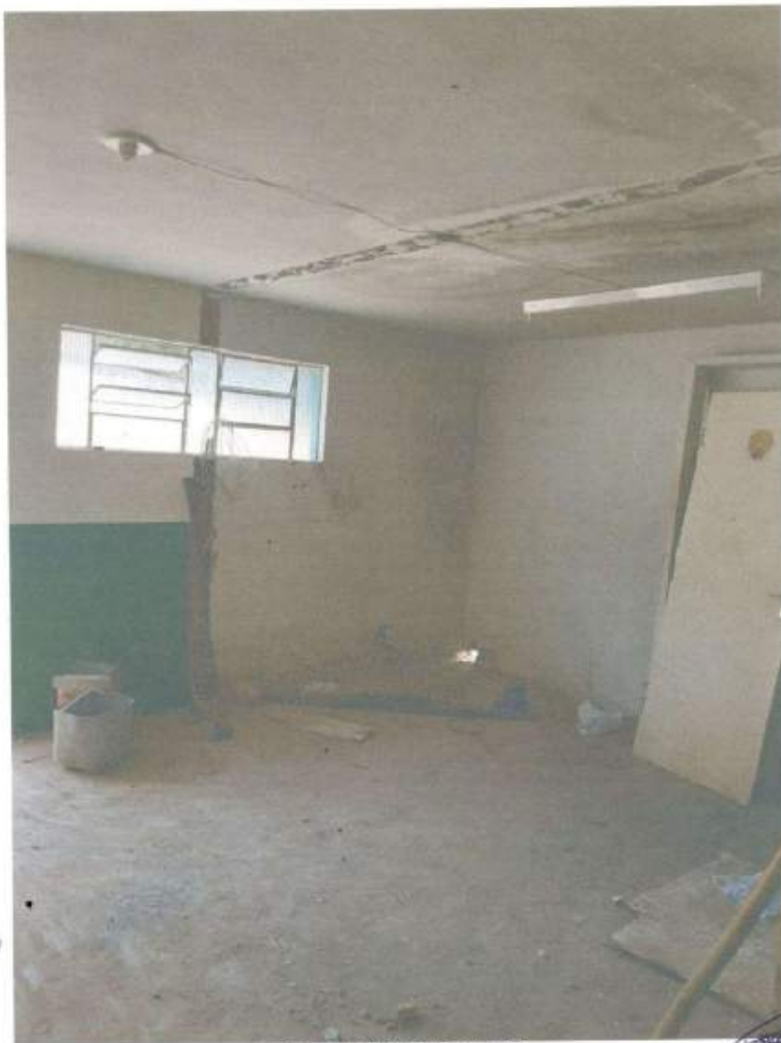
DEMOLIÇÕES DE SALAS
